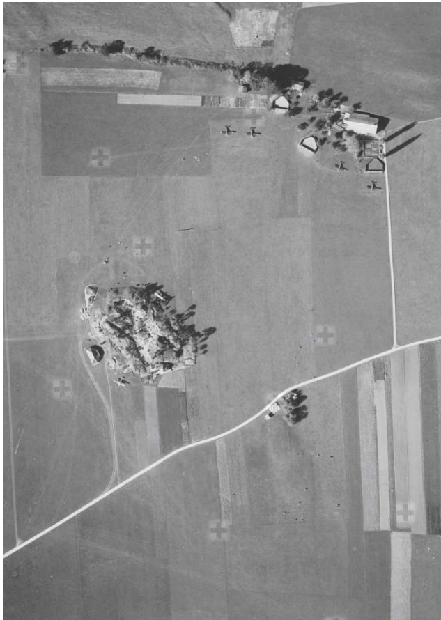
Image aérienne de l'aérodrome prise le 21.10.43 (Source : Lubis/Swisstopo)
